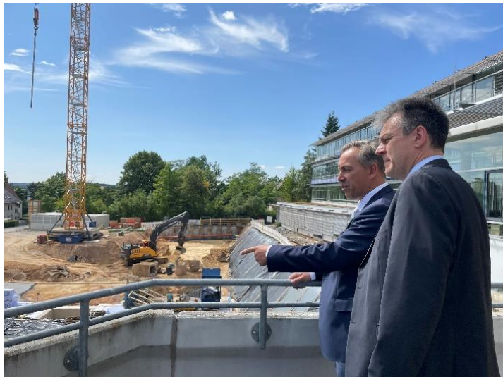
Landrat Alexander Tritthart und Schulleiter Alois Selder blicken im Juli 2023 auf die Baugrube für den Erweiterungsbau am Höchststädter Gymnasium. Foto: Pressestelle Landratsamt ERH
